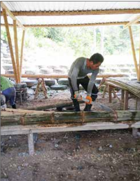
Alle Bauteile werden zugeschnitten,
