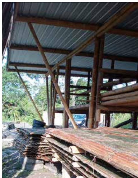
Bodenplatten am Trocknen
