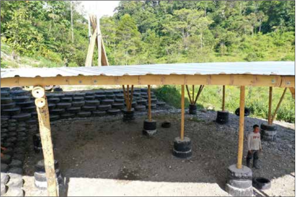
Immunisierungs- und Trocknungsanlage
