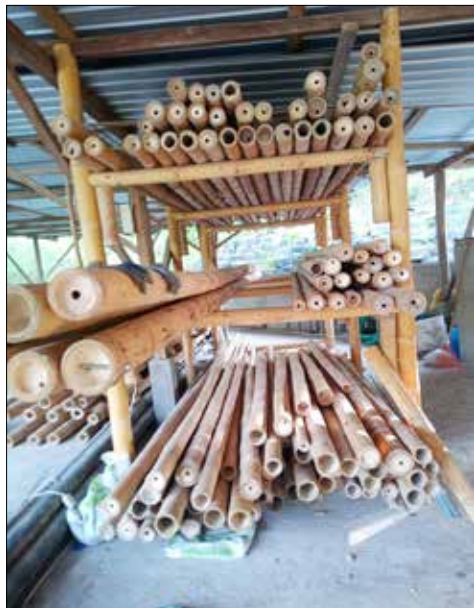
Die getrockneten Träger liegen bereit
