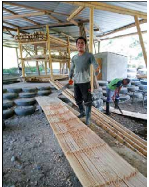
für Wände und Boden aufgebrochen
