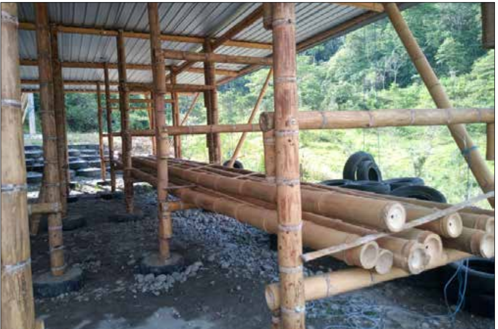
Gestelle zum Trocknen der immunisierten Stangen
